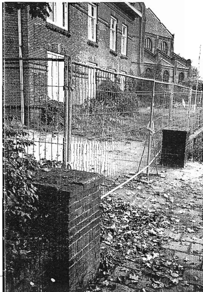
Geen koppeling tussen bouwhek en bestaande barrière.
