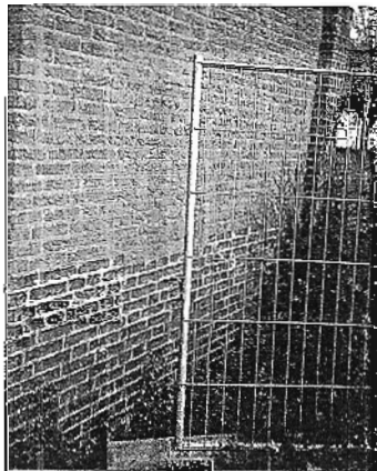
Geen koppeling tussen bouwhek en bestaande barrière.
