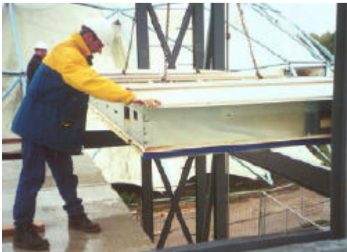
Abb. 20: Zusammenbau der Fußbodenpanele
