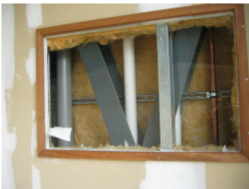
Abb. 21: Blick in eine Innenwand
