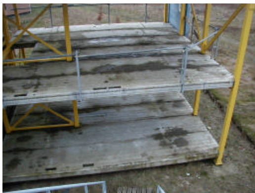
Abb. 17: Die tragende Grundkonstruktion mit den Ausnehmungen für Stiege und Installationen.
