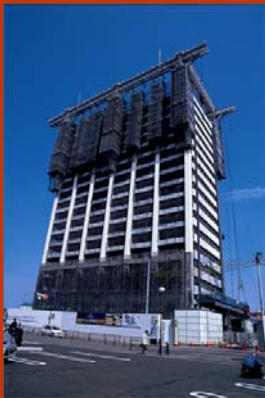
Shuttrise System (Kajima Corporation)
