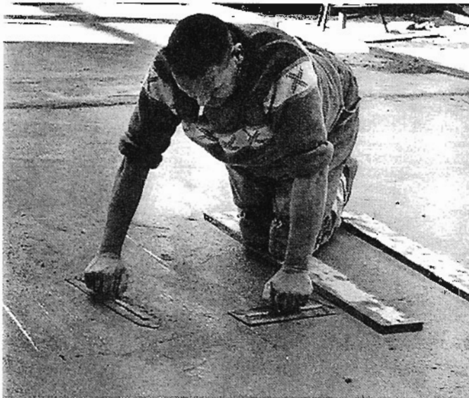
Evolutie op het gebied van vloerafwerking: achtereenvolgens de handtroffel, de troffel-machine, de troffelmachine met bestuurs-plaats en de vloerafwerkingsrobot
